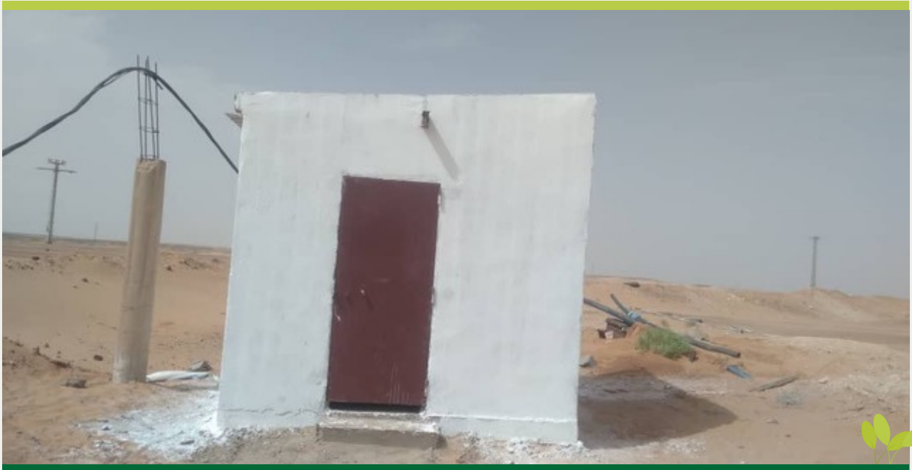
Ristrutturazione casetta contenente la pompa e l'impianto elettrico del sistema di irrigazione del CEFA
