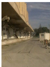
retro della struttura
