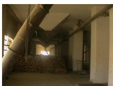
interno della struttura
